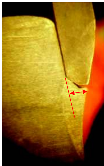
Фото 18. Сварной шов в зоне № 2.
